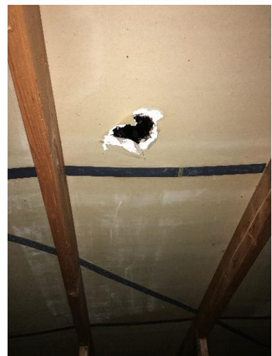
Undertag i gipsbaseret plademateriale – her med skade/gennembrydning.
